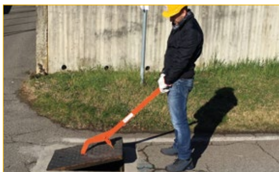
Uso de dos herramientas para tapas muy grandes.
