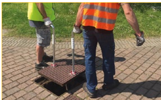
Uso con dos operadores en paralelo y herramienta separada.
